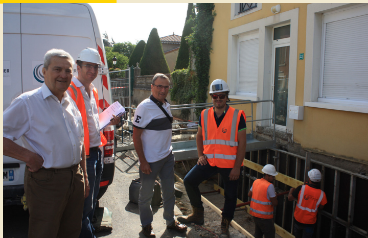
Raymond Durand et Michel Girardon visite le chantier de la rue centrale (31/07/2019)
