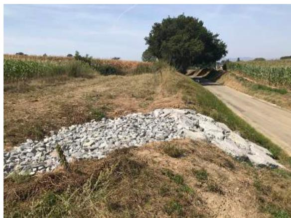
Résultat final des travaux d'aménagements route de Rechin : le comblement de la faille d'érosion qui vise une retenue et une filtration des eaux boueuses.
