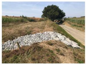
Résultat final des travaux d'aménagements route de Rechin : le comblement de la faille d'érosion qui vise une retenue et une filtration des eaux boueuses.
