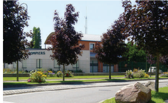
Centre d'incendie et de secours
