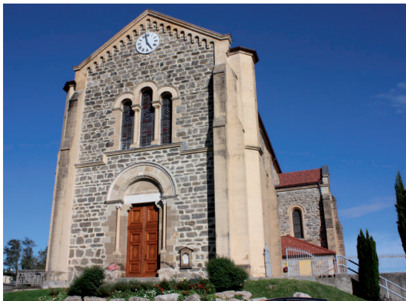
L'église St Barthélémy connaîtra des travaux de mise en conformité.
